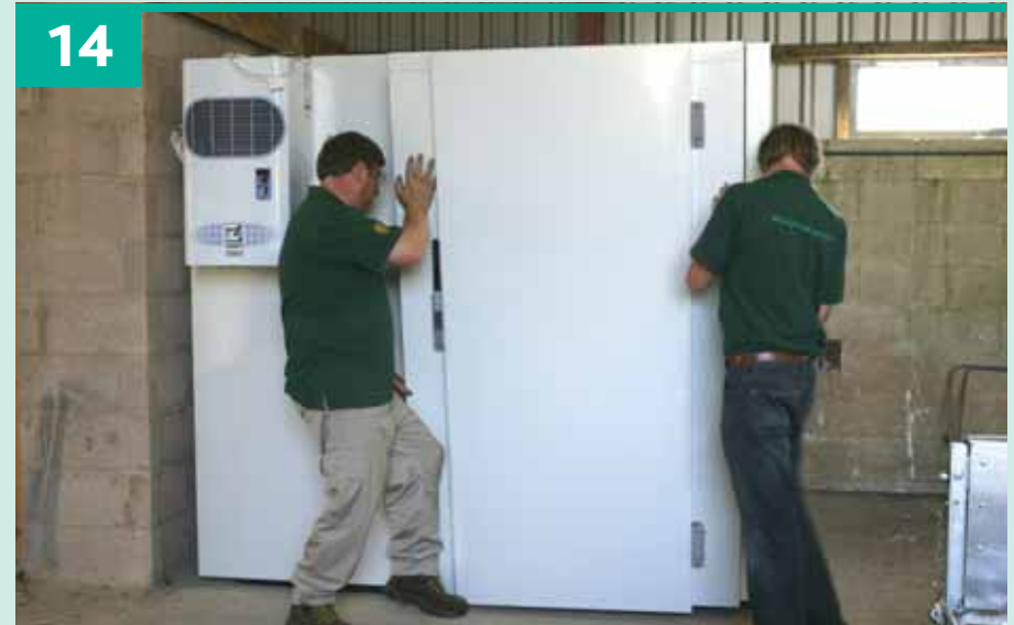
Fit door panel.
